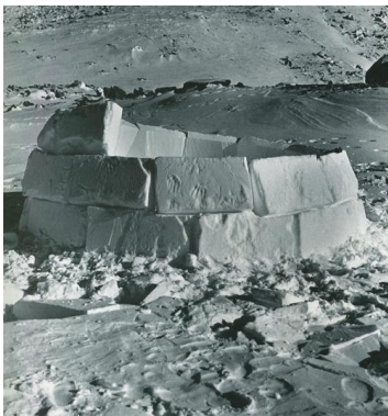
Bild 174. Snöblock läggs noggrant på plats. Varje block skärs till så den passar (efter Steltzer 1995 s.9-11).
