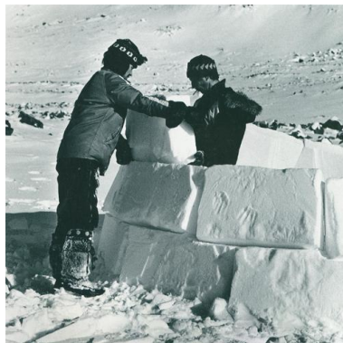
Bild 174. Snöblock läggs noggrant på plats. Varje block skärs till så den passar (efter Steltzer 1995 s.9-11).
