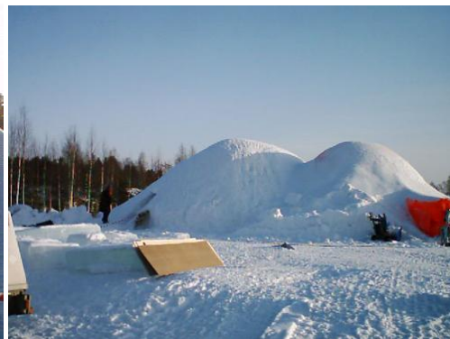
Bild 200. Dome två konstruerades sedan på samma sätt med ballongen och en dubbeligloo bildade IceDome Concert Hall (Foto Hansi Gelter)
