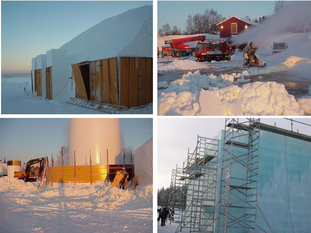
Bild 203. Byggnation av större snöanläggningar är inte olik traditionella byggnationer (Foto www.snowmagic.eu )
