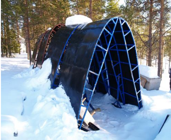
Bild 124. Förutom ballonger för domerna (restaurang och isbar) använder man mallar för konstruktion av snöhotellet. (Foto Hansi Gelter).
