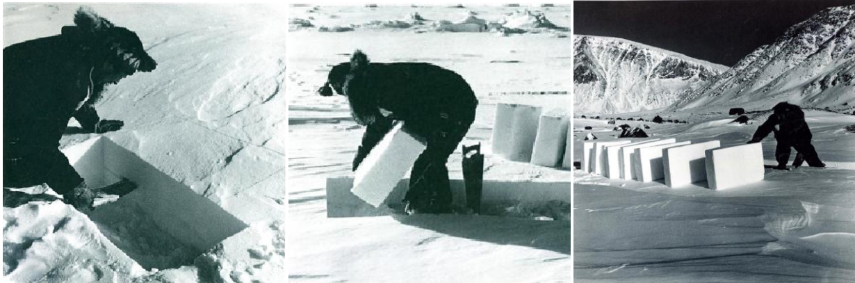
Bild 168. Snöblocken skärs ut och radas upp längs "snödiket" (efter Steltzer 1995, s 4).
