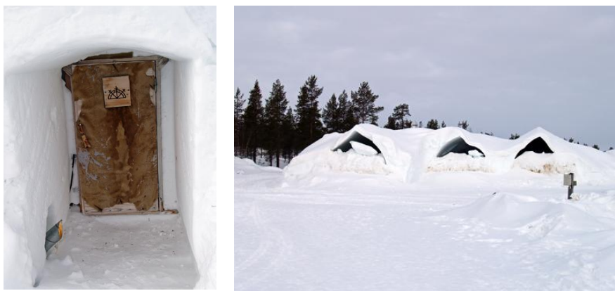
Bild 102. Ingång till snöhotellets igloorum, samt det skadade snörestaurangen som kollapsat. (Foto Hansi Gelter).
