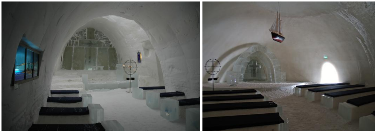
Bild 80. Snökapellet 2005 byggt med formar och 2009 byggt med 5,5 m hög ballong (Foto www.snowcastle.net och Hansi Gelter).
