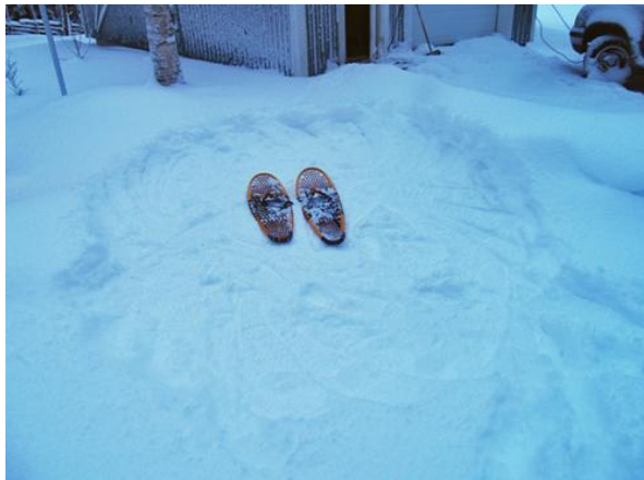
Bild 189. Den stampade grunden för quinzeen och den första hopskottade snön. (Foto Hansi Gelter)
