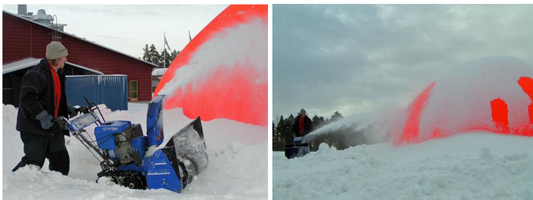
Bild 197. En snöslunga används för att täcka ballongen med snö. (Foto Hansi Gelter)
