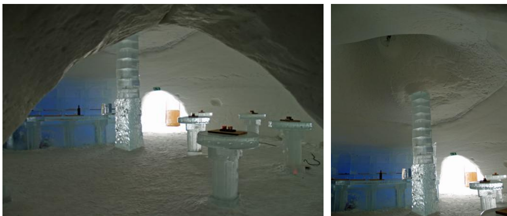
Bild 123. Det 10 meter höga domen i isbaren hade börjat svikta och bukta in, men man ansåg att det inte var någon fara för säkerheten. (Foto Hansi Gelter).
