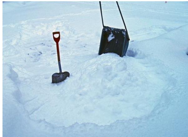
Bild 189. Den stampade grunden för quinzeen och den första hopskottade snön. (Foto Hansi Gelter)
