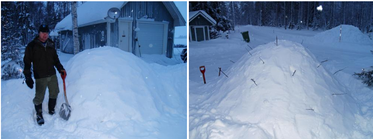
Bild 191. Efter fem dagar hade snöhögen sjunkigt ihop 20 cm, och kvistar sattes in för att markera väggarnas tjocklek. (Foto Hansi Gelter)
