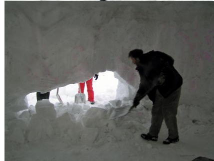
Bild 199. Med hjälp av motorsåg och spadar öppnades en öppning för anslutning av dome två. (Foto Hansi Gelter)
