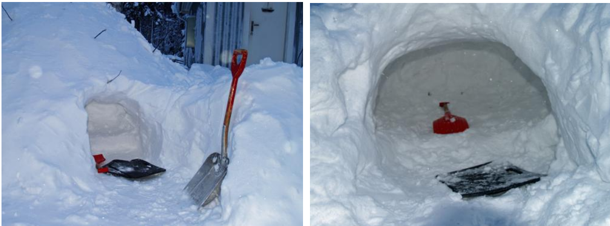
Bild 192. Efter fem dagar påbörjades utgrävandet av quinzeen. (Foto Hansi Gelter)
