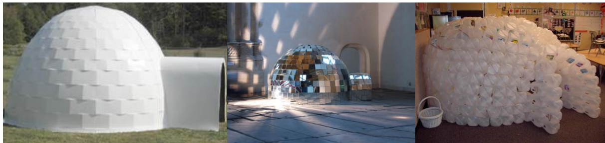
Bild 4. Igloos byggda i olika material såsom. (a) glasfiber (fiberglasstormshelters); (b) spegelglas (diskoigloo) (Shattered Satellite 2009); eller av 535 mjölkförpackningar (jmercham 2008).
