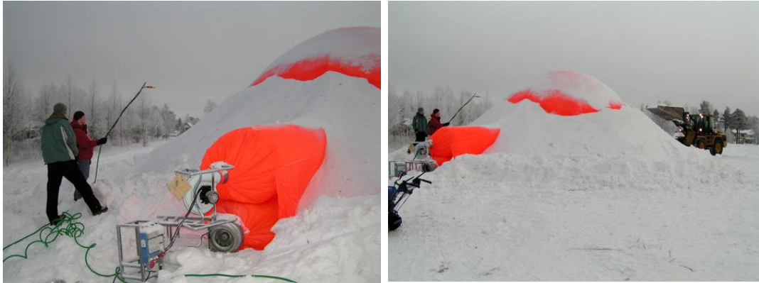
Bild 198. Vatten sprutas på så att det bildas "snis". Traktorer användes för att lyfta fram snön snöslungan. (Foto Hansi Gelter)
