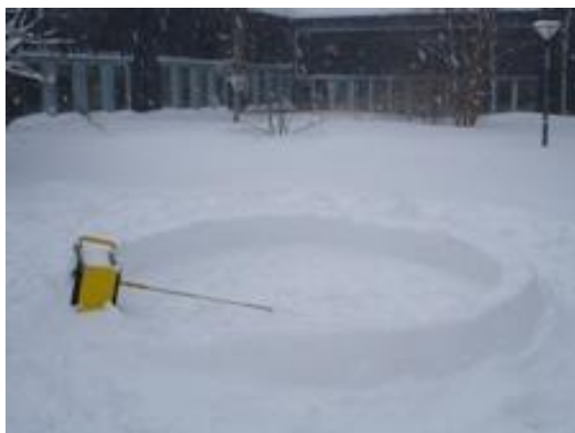
Bild 182. Första raden av igloon byggs på innergård vid LTU, Luleå (Bilder Studenter på kursen, LTU 2009)
