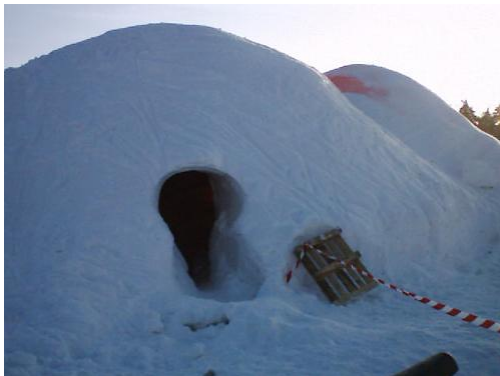
Bild 200. Dome två konstruerades sedan på samma sätt med ballongen och en dubbeligloo bildade IceDome Concert Hall (Foto Hansi Gelter)
