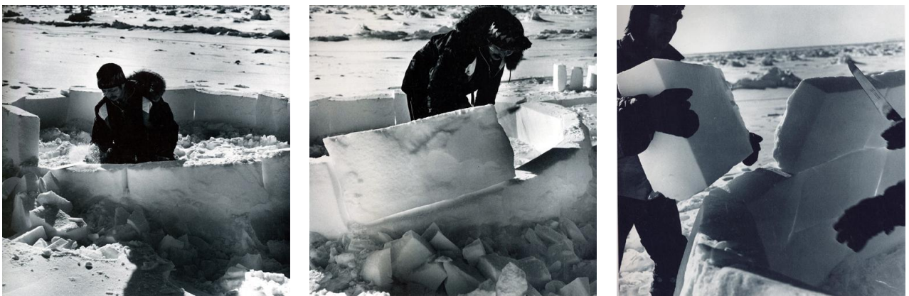
Bild 171. Första radens placering och fasning är viktig för hela konstruktionen (efter Steltzer 1995, s 7-9).
