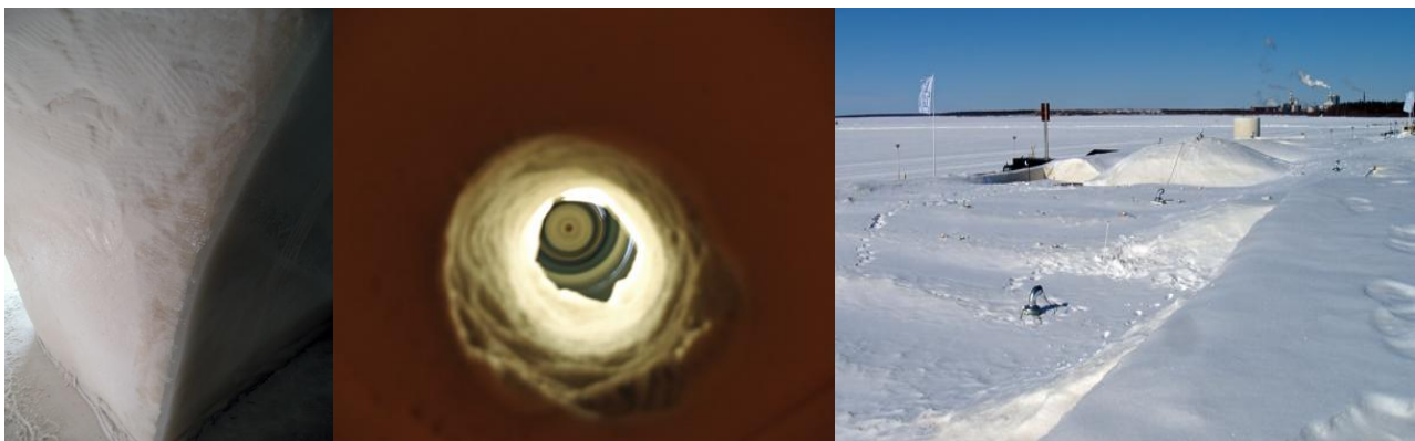
Bild 89. Iskant som grund när kapellets valv byggs på en ballong (vänster), ventilationshål med fläkt (mitten) och ventilationsrör på taket på snöhotellet för att leda bort värmen. (Foto Hansi Gelter).
