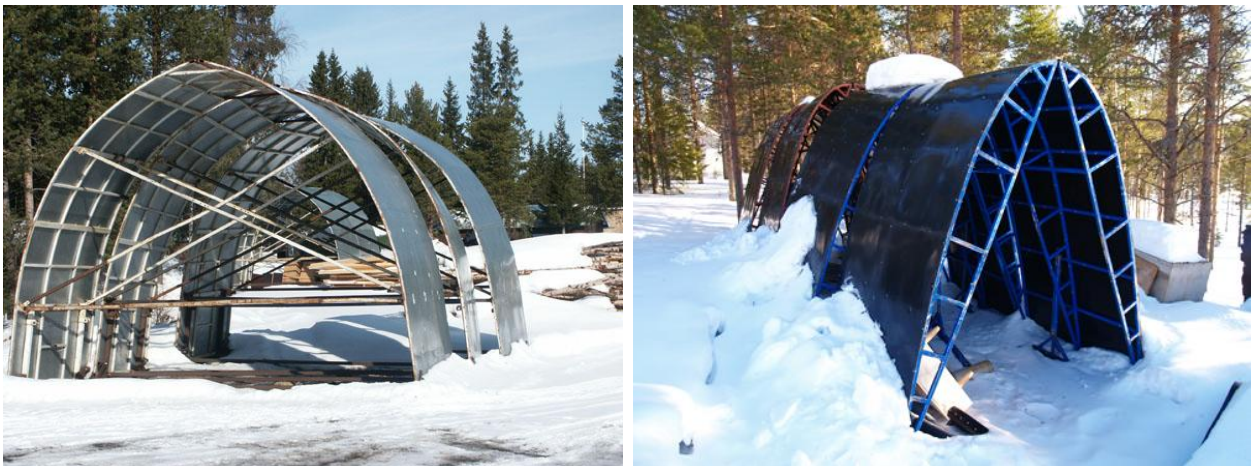
Bild 202. Formar för skapande av snöhotell, vid Icehotel i Jukkasjärvi och vid SnowVillage i Ylläs (Foto Hansi Gelter)
