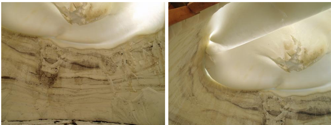
Bild 114. Deformering av taket i snöigloo vid Joulka. Man ser även att "snösmuts" kommer fram vid snösmältningen av innerväggarna. I detta stadier är igloo en säkerhetsrisk och bör ej beträdas. (Foto Hansi Gelter).
