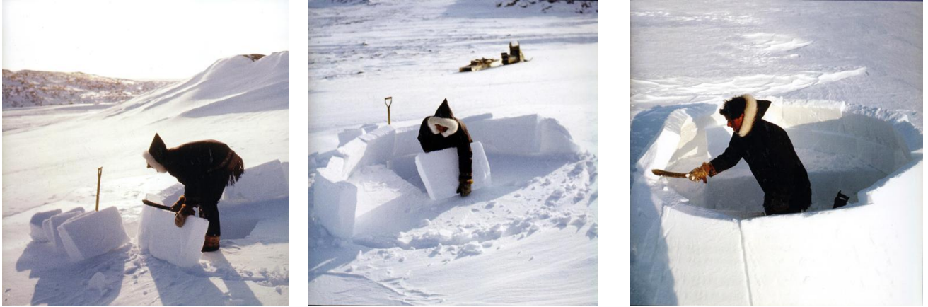
Bild 170. Första raden snöblock placeras ut och snöblocken skärs till noggrant. (efter Rau 2007 s.7-10).
