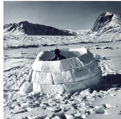
Bild 174. Snöblock läggs noggrant på plats. Varje block skärs till så den passar (efter Steltzer 1995 s.9-11).
