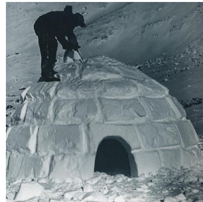
Bild 174. Sista varvet och ”kungsblocket” skärs till och läggs på plats. Slutligen görs ett ventilationshål (efter Steltzer 1995 s.15-17).
