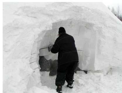
Bild 198. Vatten sprutas på så att det bildas "snis". Traktorer användes för att lyfta fram snön snöslungan. (Foto Hansi Gelter)
