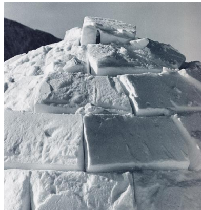
Bild 174. Sista varvet och ”kungsblocket” skärs till och läggs på plats. Slutligen görs ett ventilationshål (efter Steltzer 1995 s.15-17).
