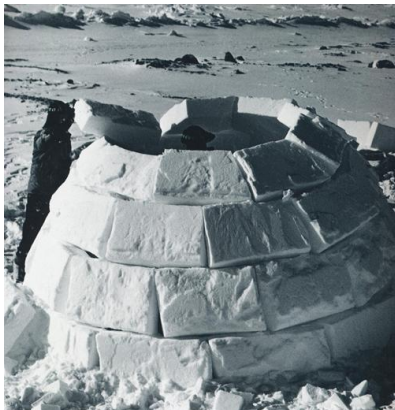
Bild 174. Sista varvet och ”kungsblocket” skärs till och läggs på plats. Slutligen görs ett ventilationshål (efter Steltzer 1995 s.15-17).
